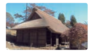
重要文化財 小林家住宅
